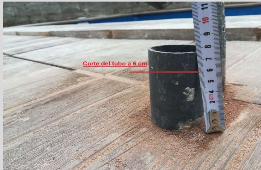
Ilustración 6. Corte del tubo a 6 cm
