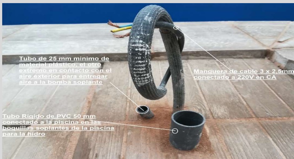
Ilustración 3. Preinstalación para Borealbox
