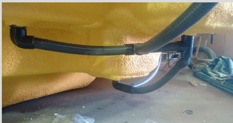
Ilustración 5. Conexión tubo 50mm a la piscina
