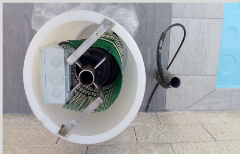
Ilustración 7. Sacar interior del dispositivo
